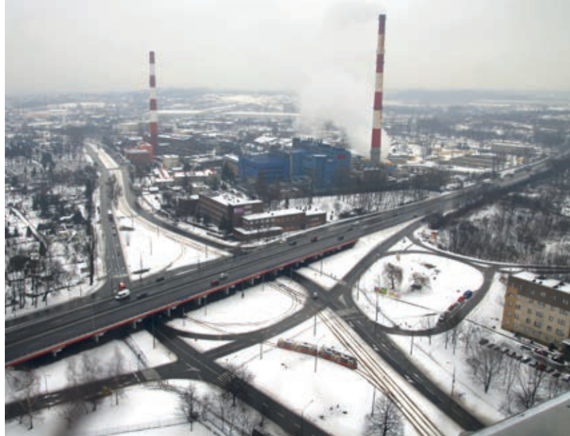
Elektrociepłownia Będzin widziana z dachu Instytutu Nauk o Ziemi w Sosnowcu | fot. Agnieszka Sikora
